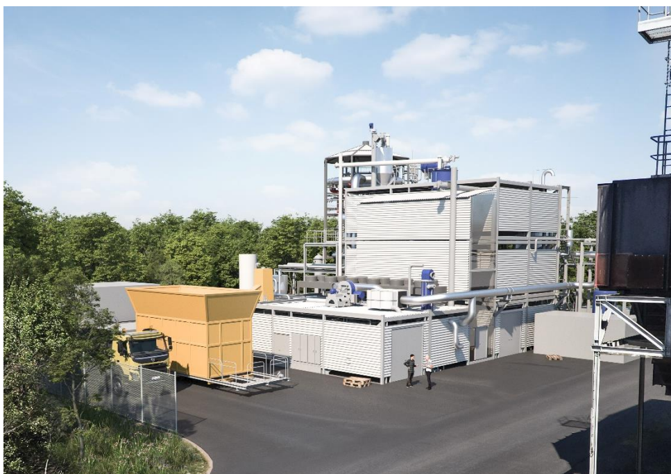
Figur 3 Illustration av anläggning för termisk förgasning av biomassa enligt den så kallade WoodRoll®-processen.
